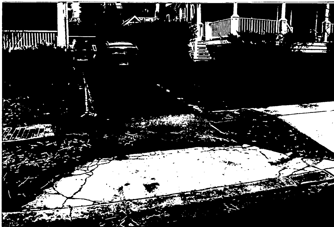
Detail: Close up of apron.
