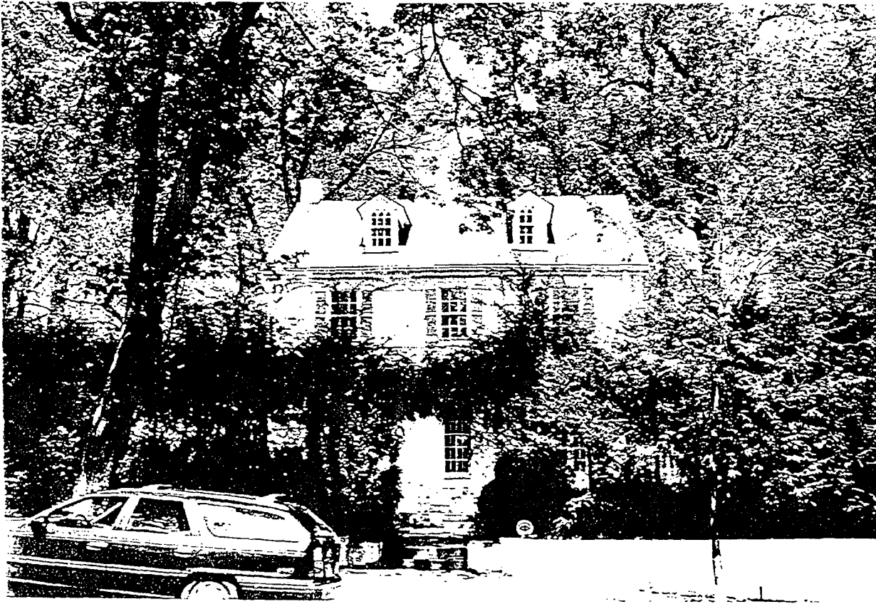
Gravatt House (c1917) 4105 Leland Street #35/115
