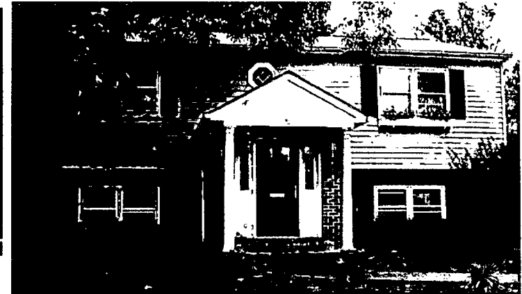
11 Columbia Avenue (Adjoining)
