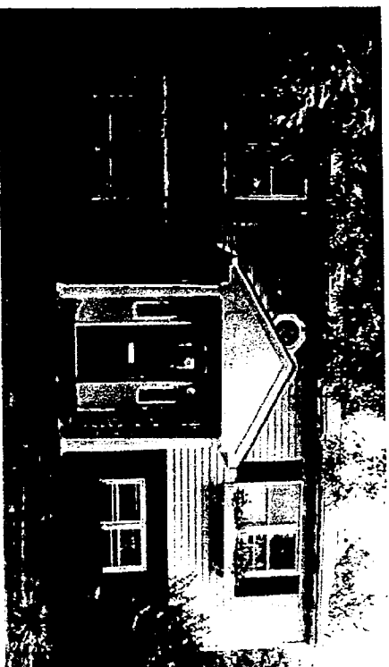
11 Columbia Avenue (Adjoining)
