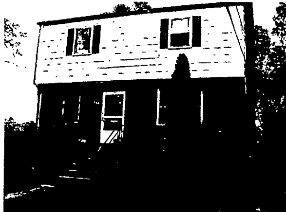
15 Columbia Avenue (Adjoining)
