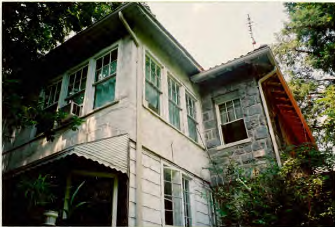
BACK - SE CORNER
