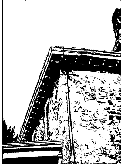
Detail SE Soffit
