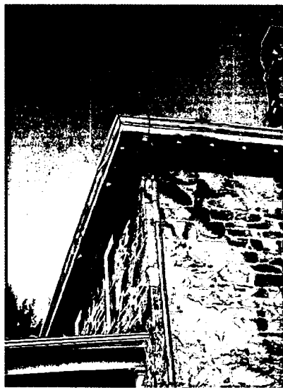
Detail SE Soffit
